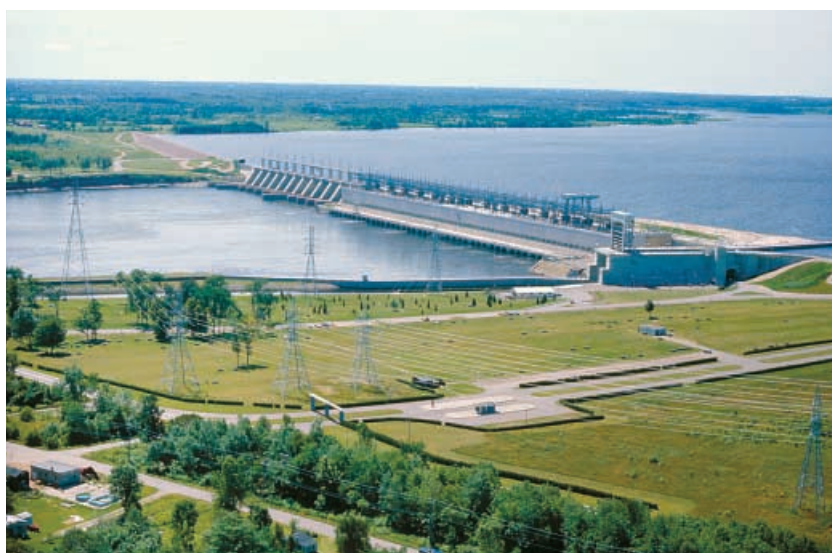
Parc et centrale de Carillon
