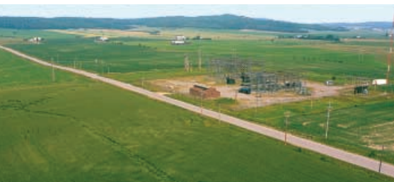
Poste de Lorrainville
