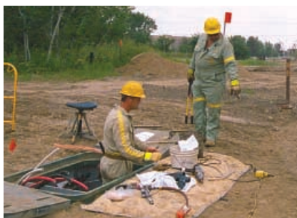
Travaux d'enfouissement du réseau de distribution
